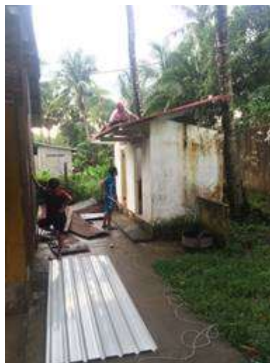
Sturmschäden werden behoben
