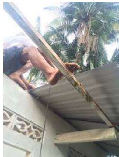
Das Dach wird neu gedeckt
